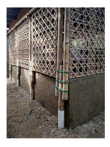
Ein grosses Vordach schützt die natürlichen und unbehandelten Materialien vor den intensiven Regenfällen des Monsuns und garantiert eine dauerhafte Konstruktion.
