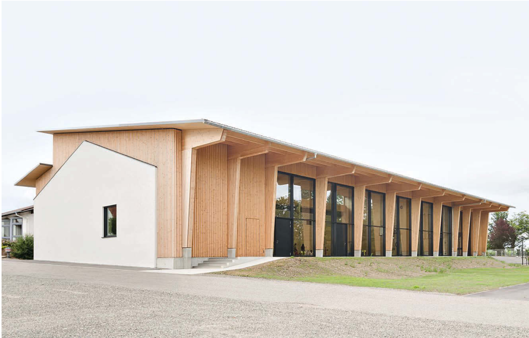
Südwestansicht der Mehrzweckhalle: Bestand und Neubau sind durch ihre Konstruktion und Materialisierung deutlich ablesbar. • The existing and new buildings are clearly distinguishable by their construction and materials.
