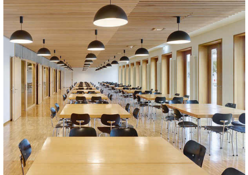
Akustisch wirksame Lamellendecke verdeckt Lüftungstechnik · Acoustically effective ceiling conceals ventilation
