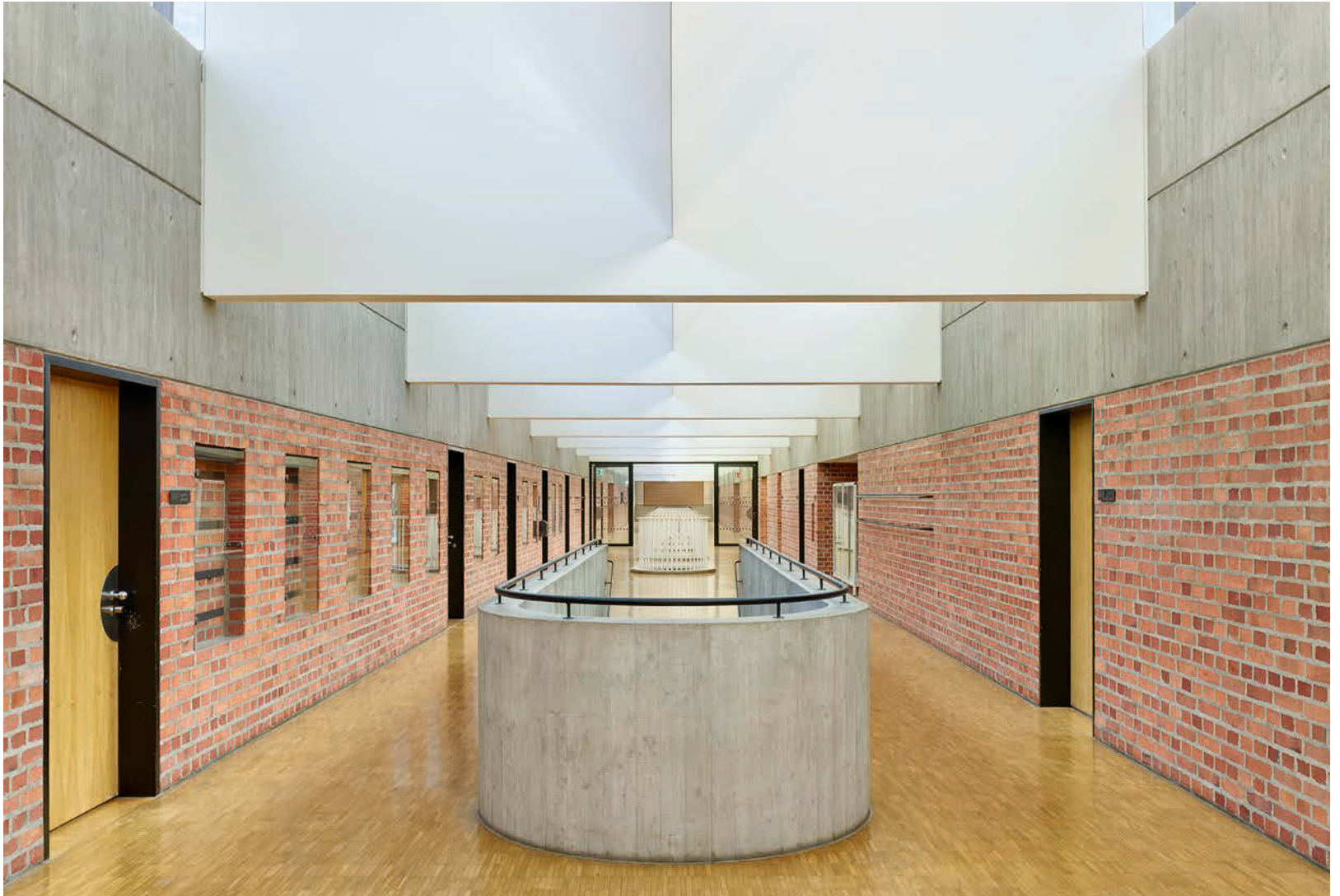
Minimalinvasiv modernisiert: Die Brüstungen und Geländer wurden geringfügig erhöht. • Minimally invasive modernisation: balustrades and railings were slightly raised.
